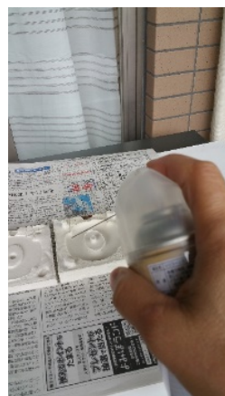
⑧シリコン吹き付け
